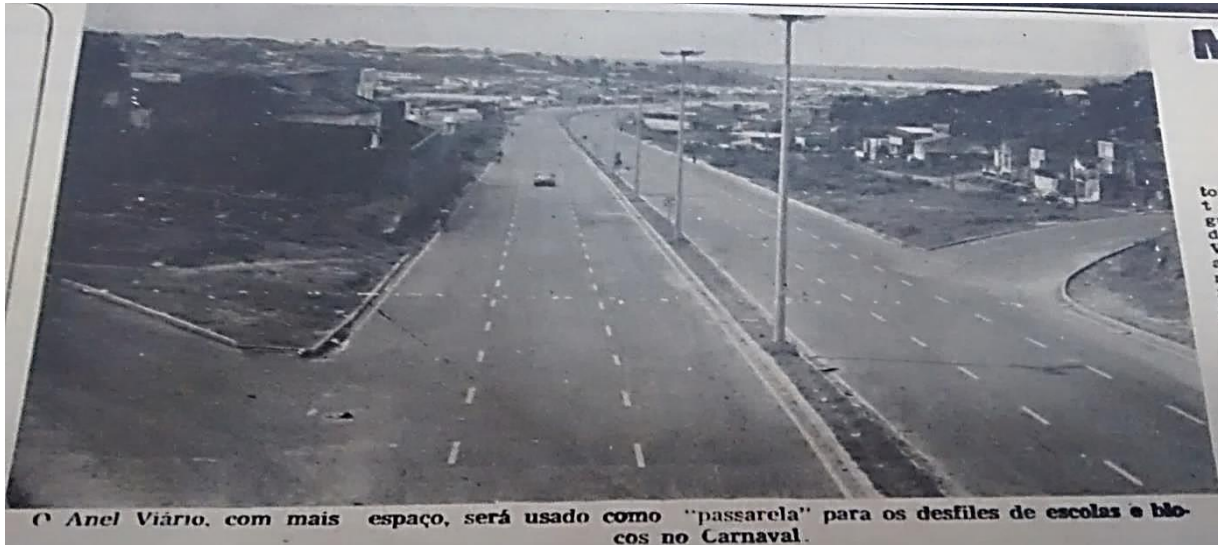
Figura 2: Avenida do Anel Viário próximo ao viaduto Getúlio Vargas, lugar em que foi construída a passarela do samba em 1979.
