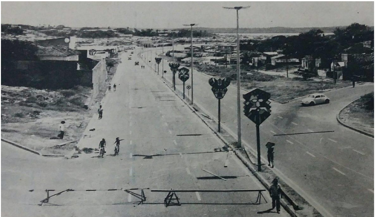
Figura 11 – Espaço destinado para a Passarela do Samba de São Luís.
