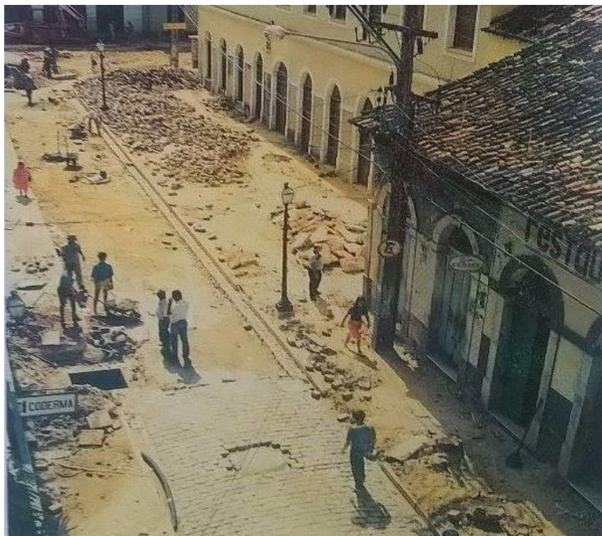
Figura 06: Foto da obra do Projeto Reviver na Rua Portugal. Fonte: CAFETEIRA, 1994.
