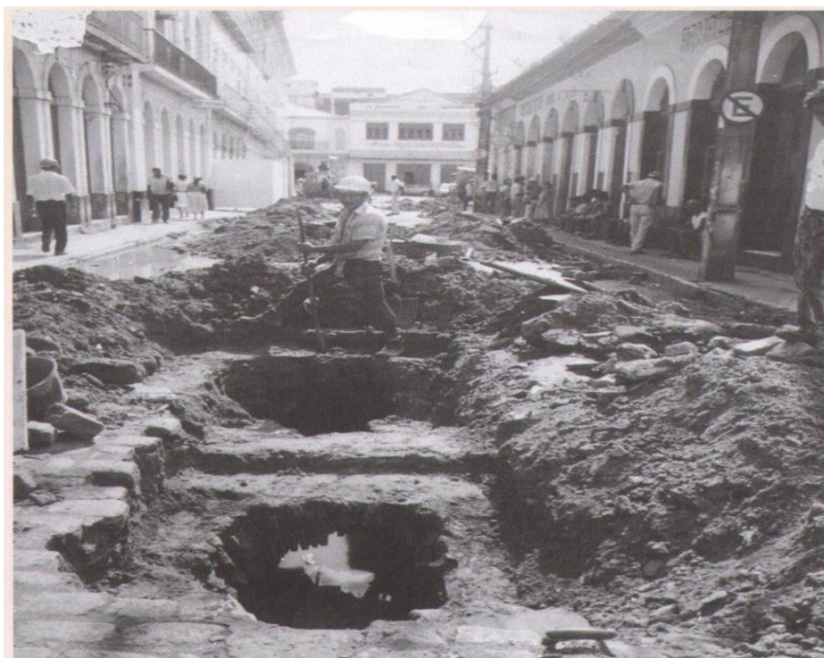
Figura 10: Foto da obra de esgoto e drenagem no centro histórico de São Luís. Fonte: ANDRÈS, 2012.
